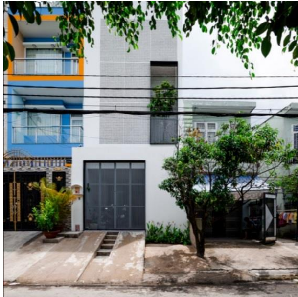
Figura 91: Vista externa da fachada. Fonte: Kingkien Photography (2016).
