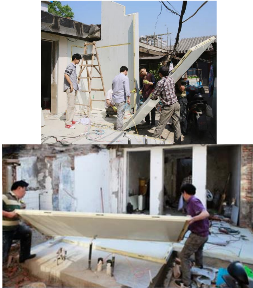
Figura 53 e 54: Imagens da montagem da casa a partir do piso pronto. Fonte: Gao Tianxia, People's Architecture Office (2016)
