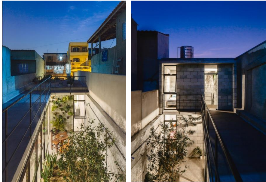
Figuras 12 e 13 : Vistas a partir do primeiro piso, em direção à rua e para os fundos. Fonte: Pedro Kok (2015)
